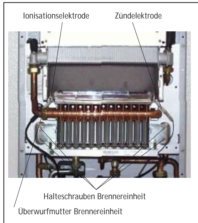
Bild: Reinigen des Brenners
