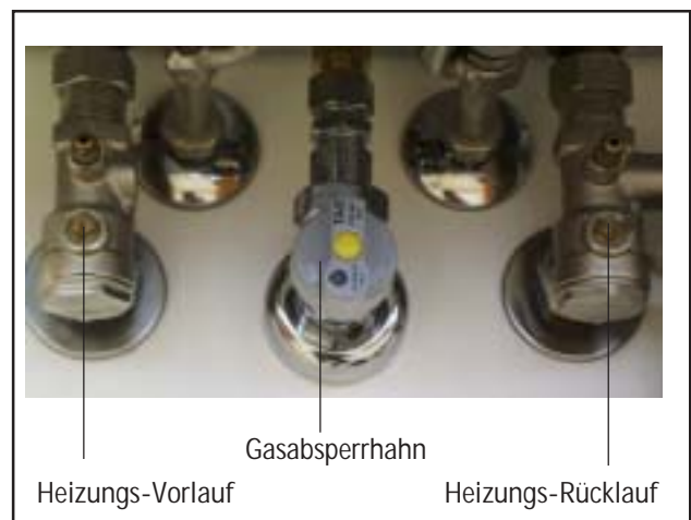
Bild: Absperrarmaturen
