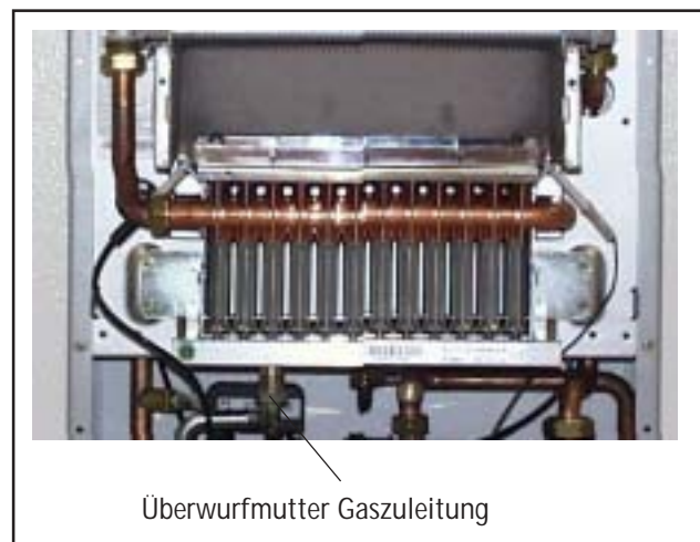
Bild: Gaszuleitung
