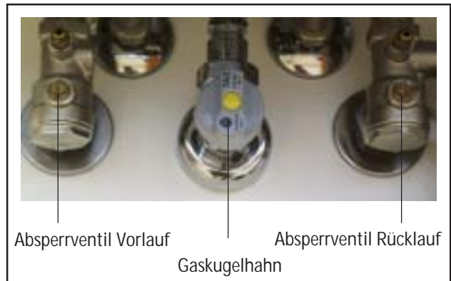
Bild: Absperrreinrichtungen
