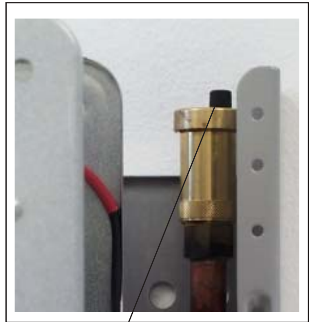
Bild: Entlüfterschraube am Schnellentlüfter
