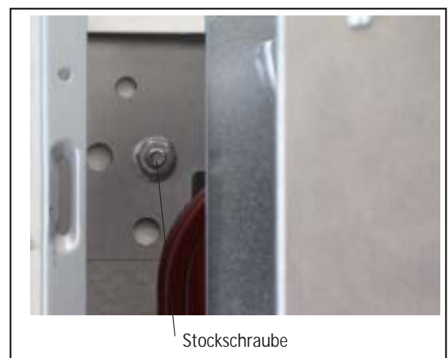
Bild: Gasterme montieren mit Stockschrauben
