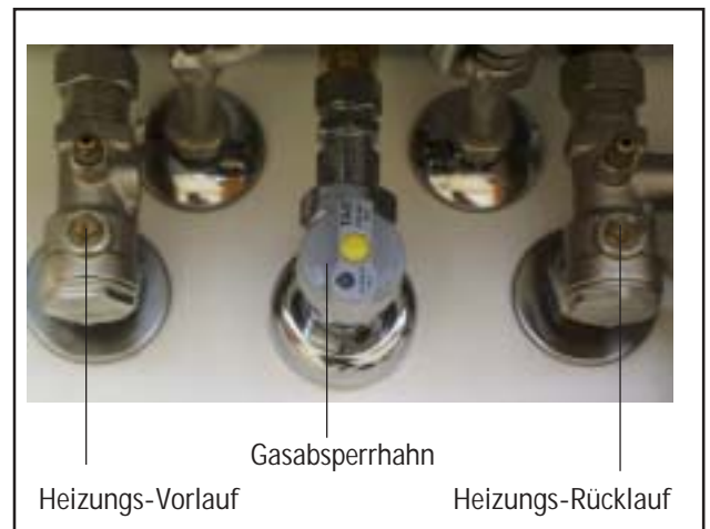
Bild: Absperrarmaturen
