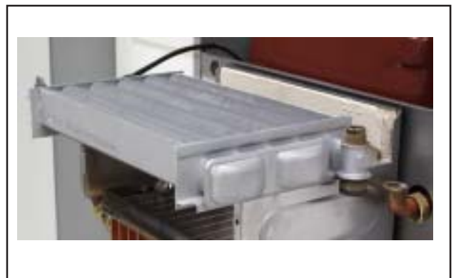
Bild: Demontage Heizwasserwärmetauscher
