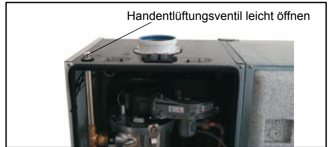
Bild: Manuelles Entlüftungsventil
