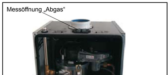
Bild: Abgasmessung bei geöffnetem Gerät
